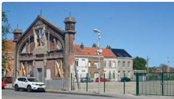
La façade de l'espace communal des solidarités arbore un tout nouveau visage. Pour améliorer le confort thermique à l'intérieur du bâtiment et ainsi réduire les besoins en rafraîchissement, la municipalité a opté pour une peinture thermique utilisée avec membrane (réduction jusqu'à 4 degrés lors de fortes chaleurs).
